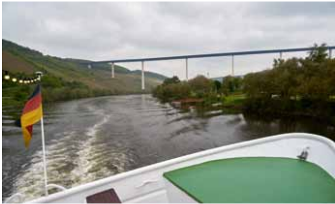
Die neue Mosel-Hochbrücke
