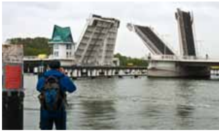
Kappeln, geöffnete Schleibrücke
